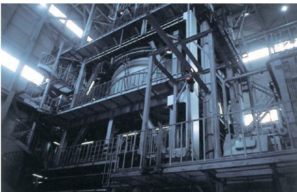
M浄化センター 福岡県
