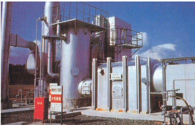
縦置型煙管式廃熱ボイラ
