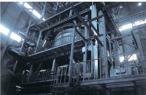
M浄化センター 福岡県
