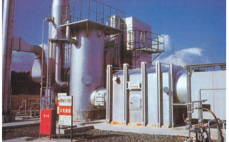
縦置型煙管式廃熱ボイラ
